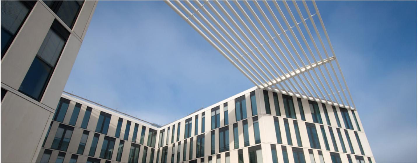
Für die Investitionsbank des Landes Brandenburg (ILB) in Potsdam haben wir drei Flugdächer angefertigt. Die Lamellen der weitgespannten Stahlkonstruktionen bestehen aus Rechteckprofilen.
